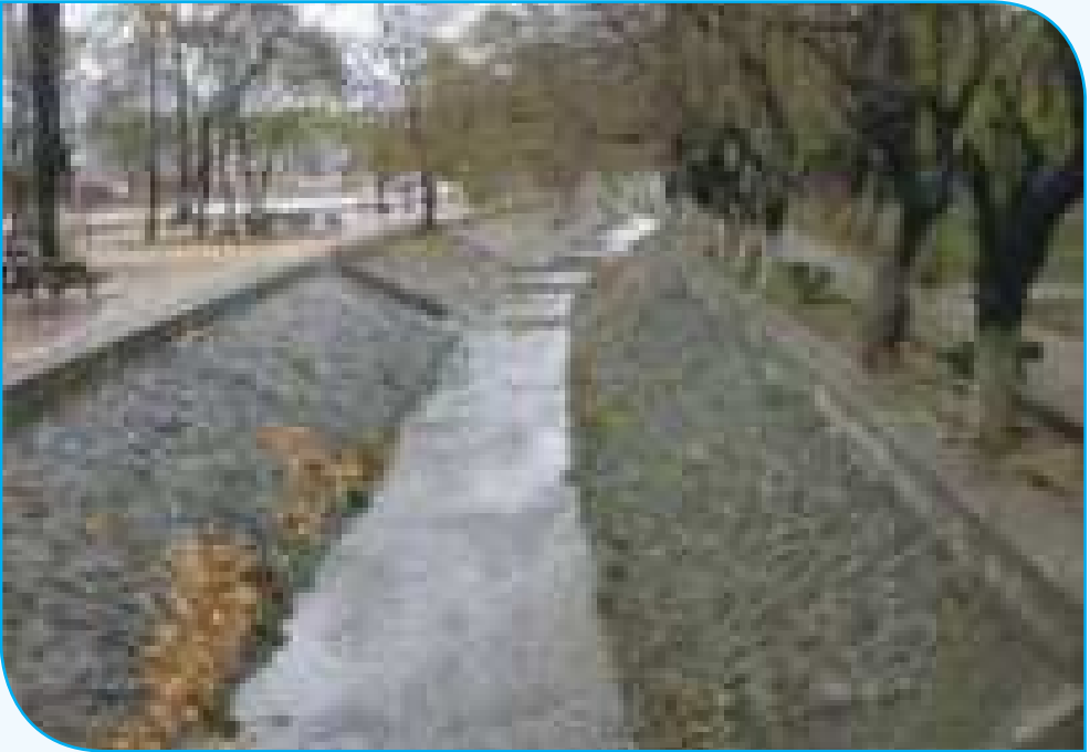
Resim 2.43: Kanal Şevlerinin Korunması Amacıyla Yapılan Harçlı Taş Pere Kaplama
