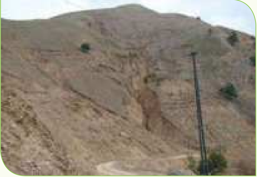
Resim 1.9: Oyuntu Erozyonunun İlerlemiş Hali, Muratlı Köyü - Kahramanmaraş - 2009
