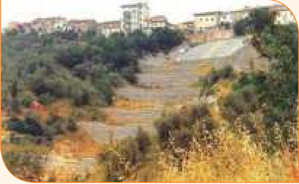
Resim 3.119: Harçlı Sekilerle Heyelanlı Yamaç Sağlamaştırılmış ve Daha Sonra Ağaçlandırılmıştır.
