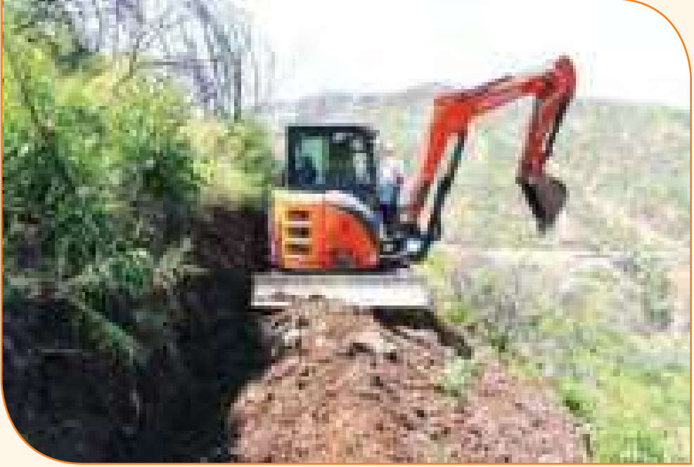
Resim 3.32: Mini Ekskavatörle Buror Tipi Teras Yapımı, Samandağı - Hatay - 2013
