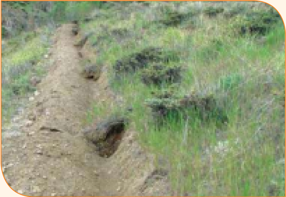
Resim 3.36: İşçi İle Terasda Kompartuman Tesisi
