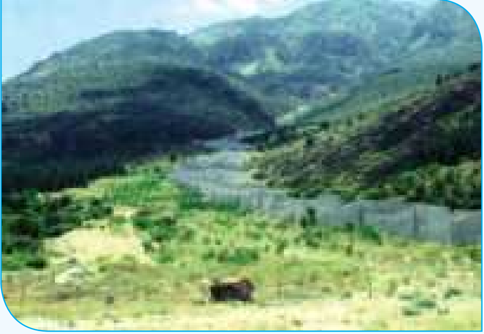
Resim 2.72: 1995 Yılında Meydan Gelen Sel Felaketinden Sonra, Sel Zararının Önlenmesi Amacıyla, Senirkent Doğru ve Suyolu Deresinde Yamaçlarda Ormanlaştırma, Oyuntularda Tersip Bentleri, Islah Sekileri, Taban Kuşakları İnşa Edilmiştir. Senirkent İlçesi - 2001
