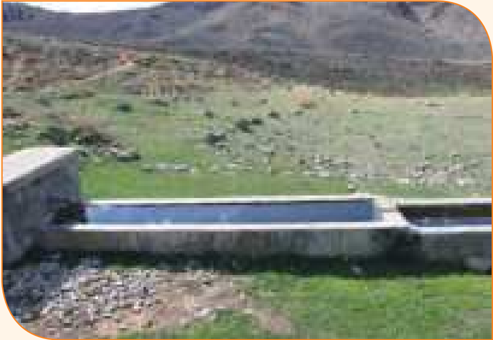
Resim 3.66: Betondan Yapılmış Sıvat, Göksu Havzası - Taşkent - Konya - 2014
