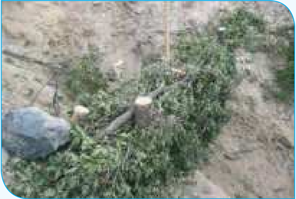
Resim 2.38: Çalı Demetli Canlı Eşik
