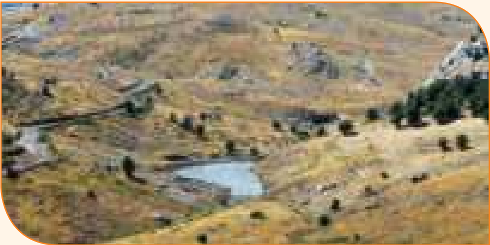
Resim 3.70: Küçük Boyutta İnşa Edilen Hayvan İçme Suyu Göletti, Sorgun Merası - Erdemli - 2015
