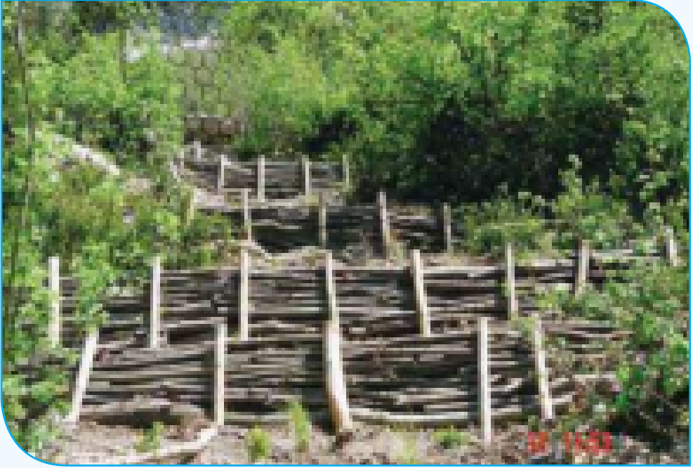
Resim 2.50: Cansız Kazık ve Ağaç Dalları İle Tesis Edilmiş Yamaç Islahı, Fransa
