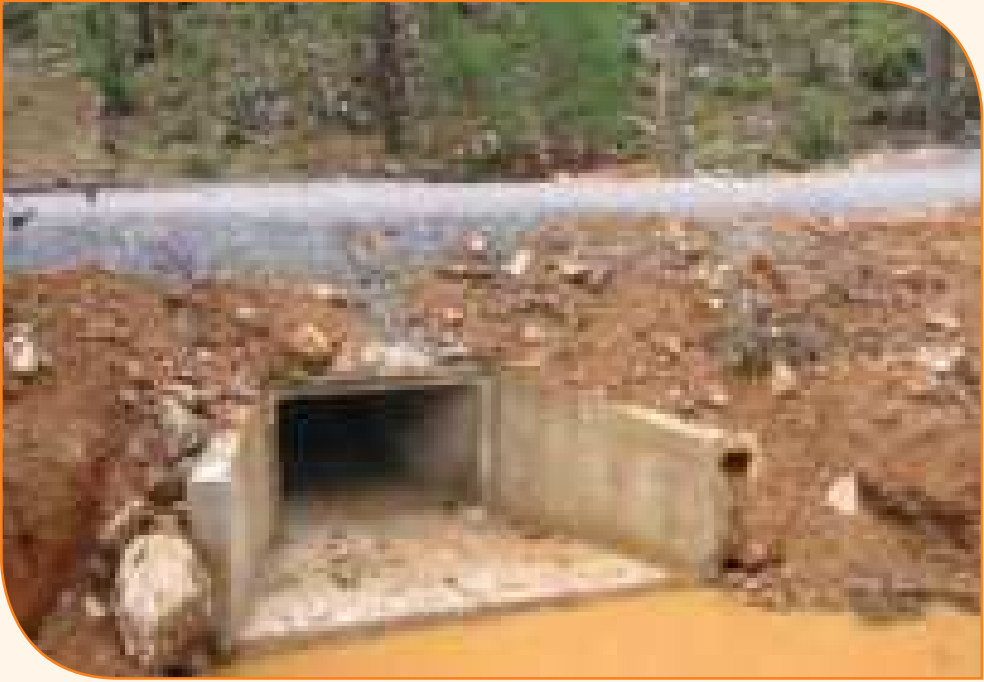
Resim 3.22: Alt Yapısı Tamamlanmış Orman Yolu
