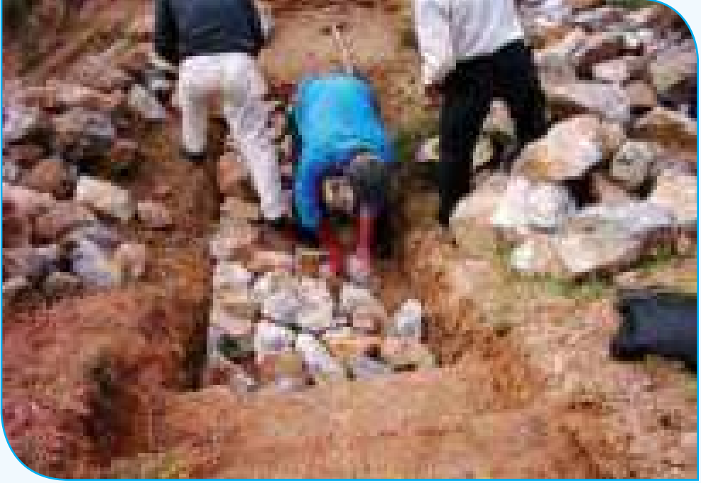
Resim 2.30: Kuruduvar Eşik Yapım Aşamaları; Taşların Dizilmesi
