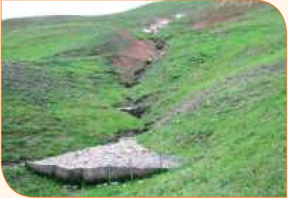
Resim 3.64: Merada Oyuntu Rehabilitasyonu, Ağrı - 2014
