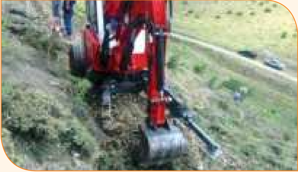
Resim 3.31: Örümcek Ekskavatörle Toprak İşlemesi
