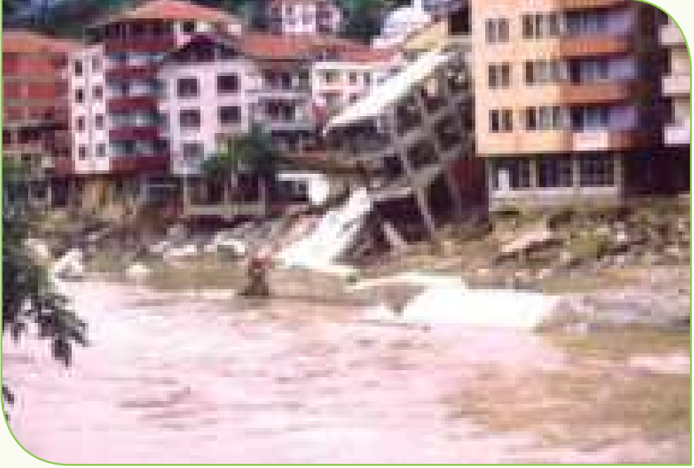
Resim 1.13: Sel Zararının Nedeni, Sel Yatağındaki Yapılaşmadır, Devrek - Zonguldak - 1998
