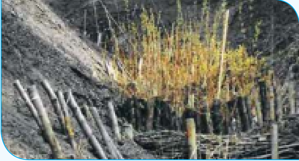
Resim 2.52: Topraklı Dere Tabanlarında Canlı Kazıklarla Tesis Edilmiş Oyuntu Islahı, Fransa
