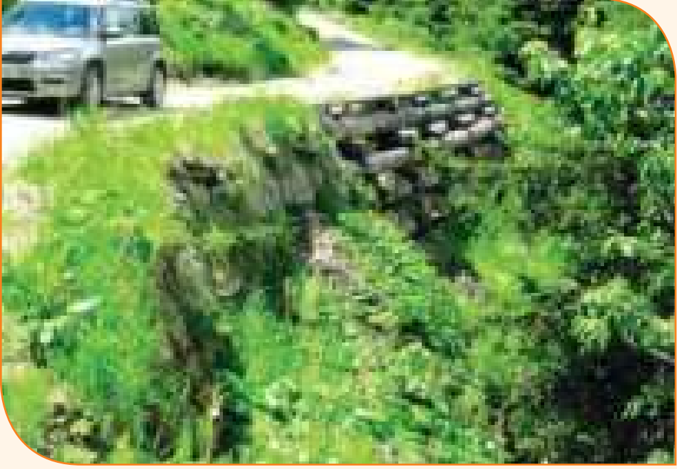
Resim 3.21: Alt Yapısı Tamamlanmış Orman Yolu
