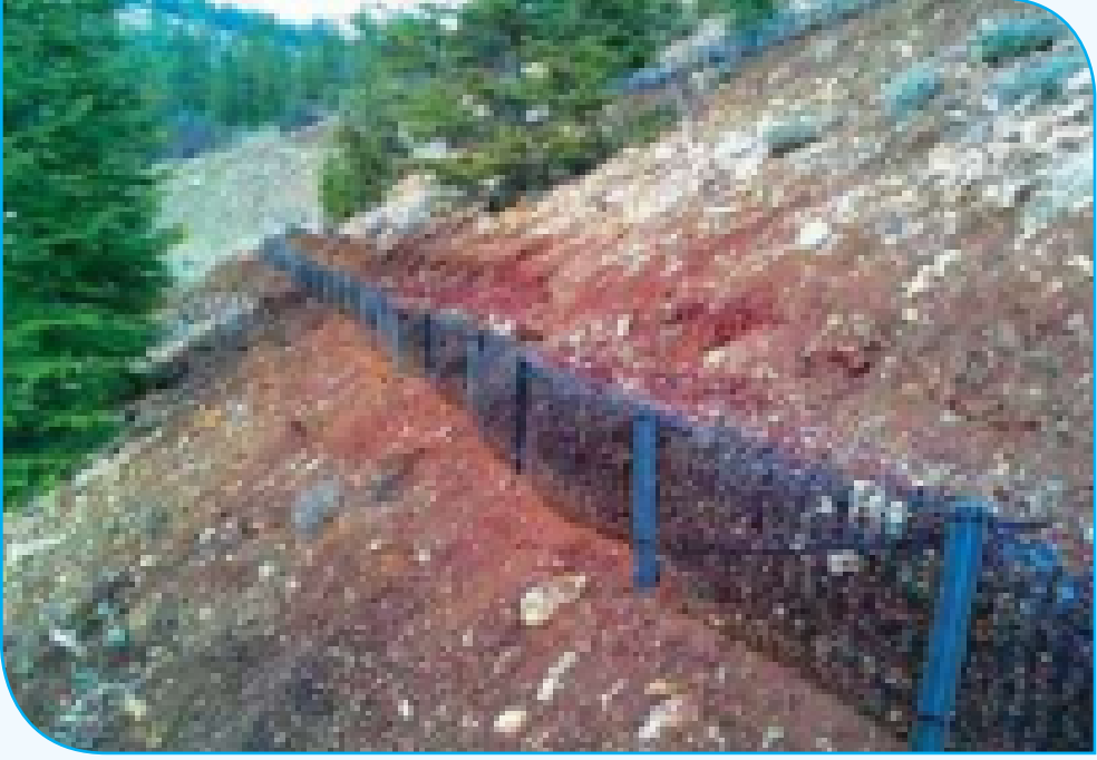
Resim 2.16: Geosentetik Çit Teras
