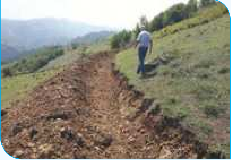
Resim 2.24: Kaplamasız Çevirme Hendeği
