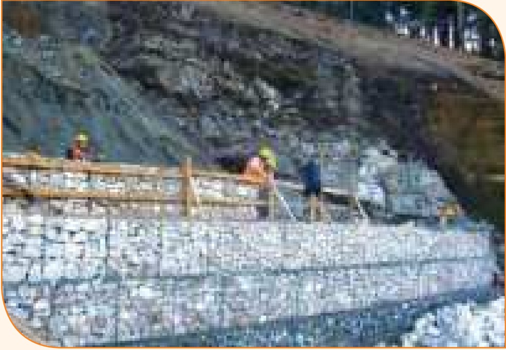
Resim 3.120: Şev Kayma ve Akmalarına Karşı Yapılmış Gabion Duvar
