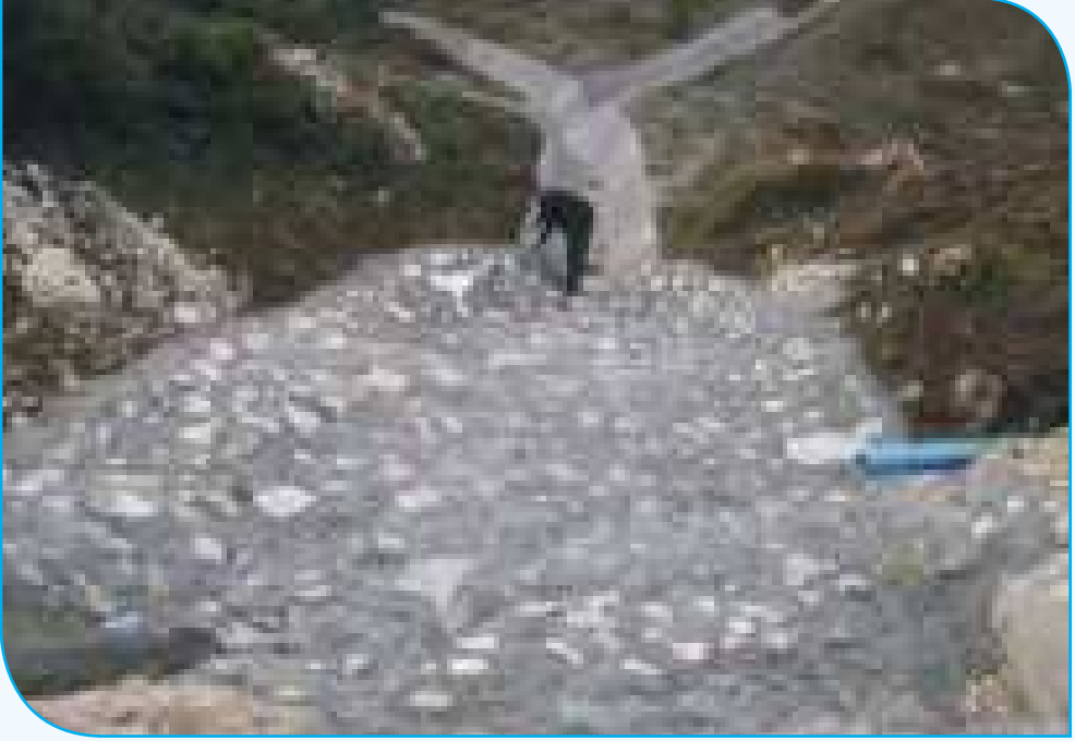
Resim 2.42: Yamaç Islahında Drenaj Kanal Çıkışına Yapılan Harçlı Taş Pere Kaplama
