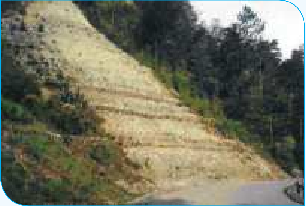
Resim 2.58: Kafes Tel Çit İle Yamaç Islahı, Tesisten Sonra Teraslar Yöreye Uygun Fidanlarla Ağaçlandırılır, Fransa
