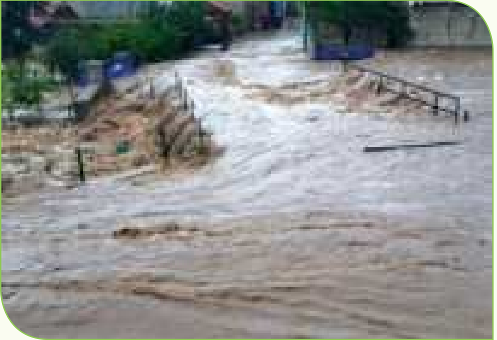
Resim 1.16: Dere Yatağına Uygun Ölçüde Yapılmayan Köprü ve Menfezlerin Neden Olduğu Sel ve Taşkın, Akyuva - Şuhut - Afyon - 2014
