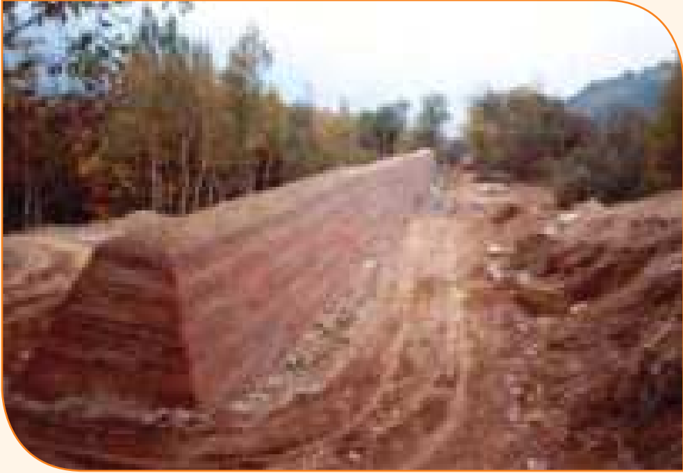
Resim 3.122: Geosentetik Malzeme İle Yapılmış Toprak Dolgu, Kaya Tutma Duvarı
