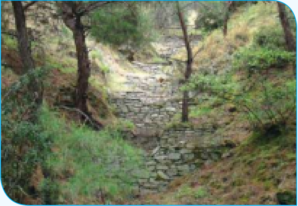
Resim 2.31: Kuruduvar Eşik Yapım Aşamaları; Bitirilmiş Hali, Nazilli - Aydın - 2011
