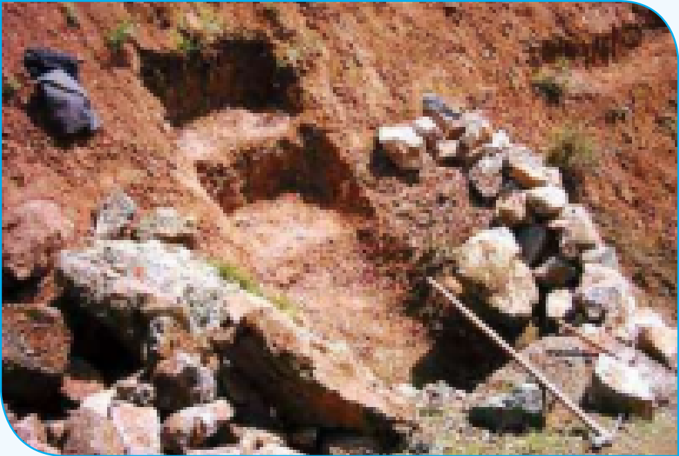
Resim 2.29: Kuruduvar Eşik Yapım Aşamaları; Temel Kazısı Yapılmış
