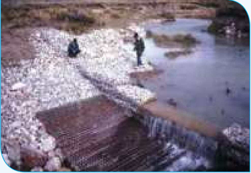
Resim 2.74: Harçlı Seki İle Kombine Edilmiş Taş Dolgu Kıyı Tahkimatı, Arizona - Amerika - 1996
