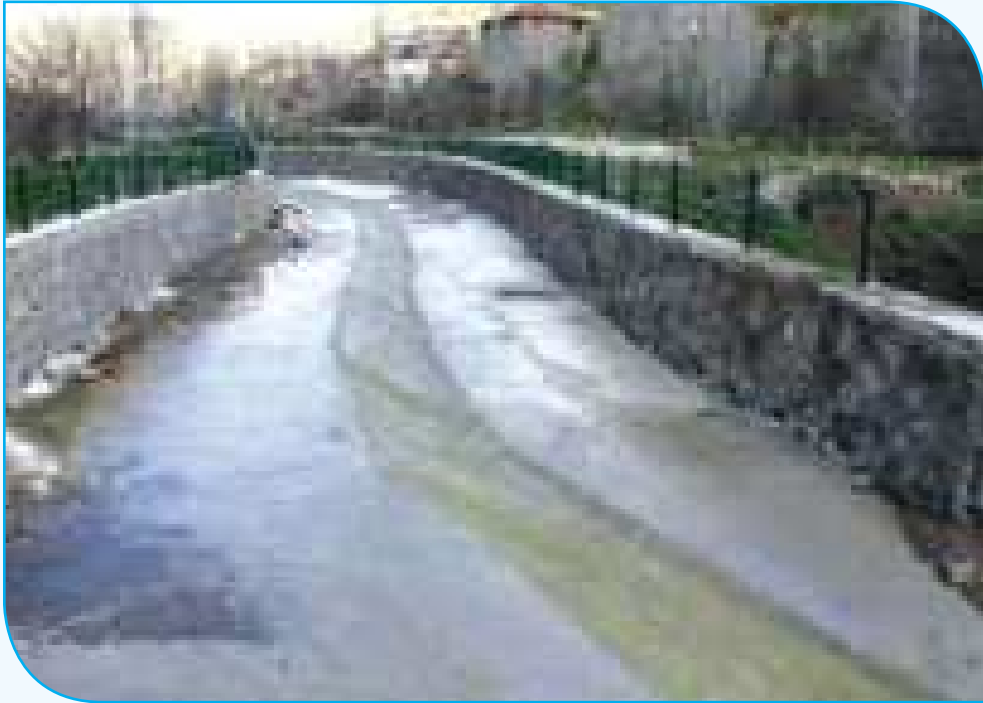
Resim 2.73: Kıyı Duvarları, Dadak Köyü - Şuhut - Afyon - 2015
