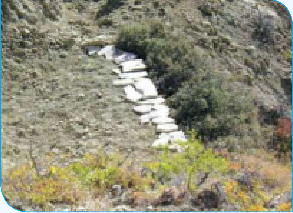
Resim 2.39: Çalı Demetli Toprak Eşik
