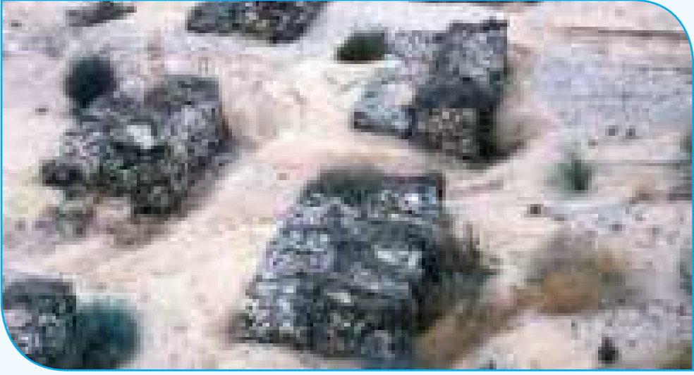
Resim 2.46: Suyun Hızını Azaltmak Amacıyla Dere Mecrasına Şaşırtmalı Şekilde Yapılmış Tel Kafes Sandıklar, Malatya - 1994
