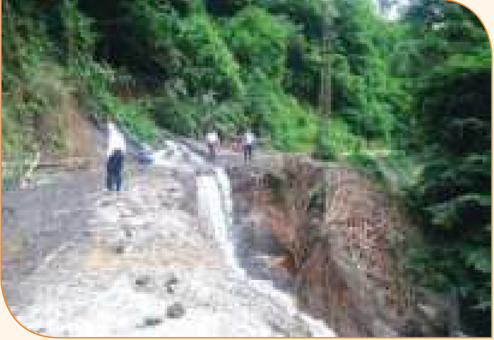
Resim 3.19: Alt Yapısı Tamamlanmamış Orman Yolu
