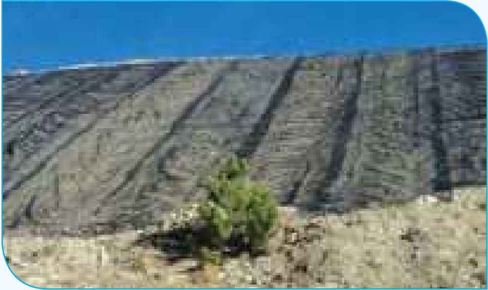
Resim 2.20: Serme Geosentetik İle Yüzey Kaplama
