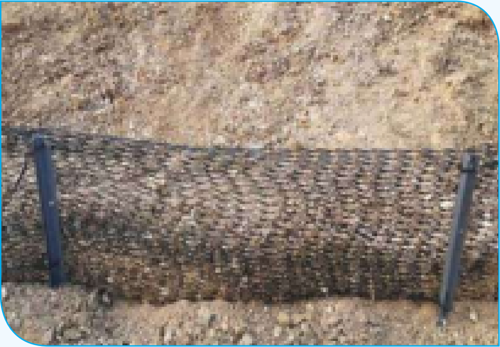
Resim 2.17: Geosentetik Çit Teras
