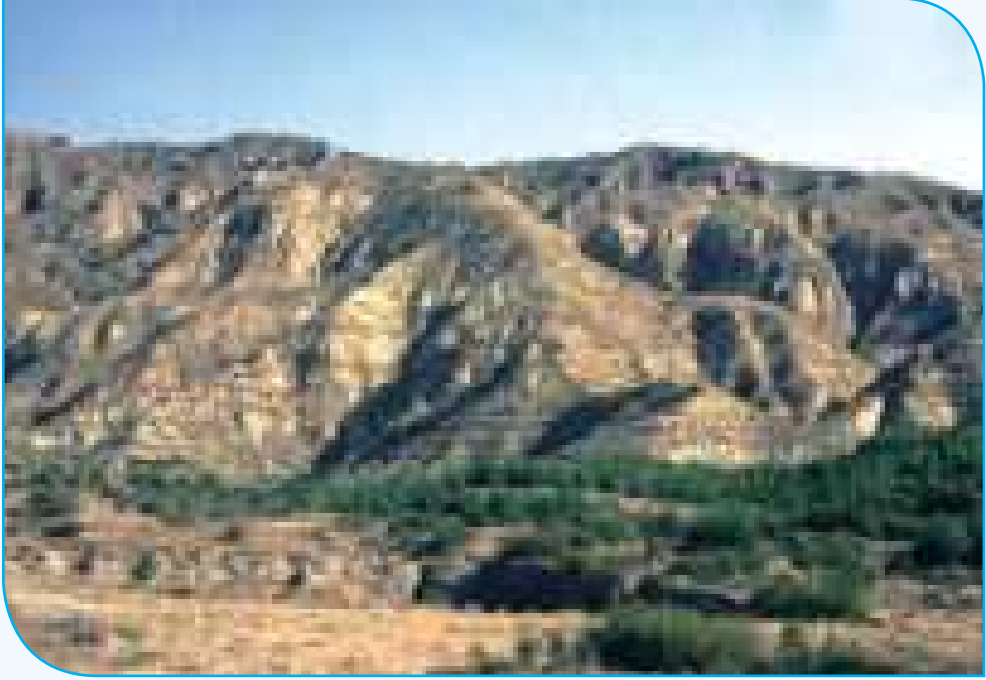
Resim 2.15: Çalı Demetli Terasla Yapılmış Yamaç Islahı, Kastamonu - 1994
