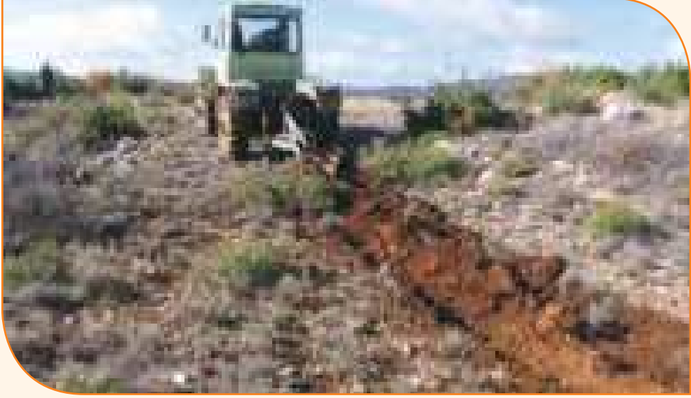
Resim 3.23: Lastik Tekerlekli Traktörle Gradoni Şeklinde Üst Toprak İşlenmesi
