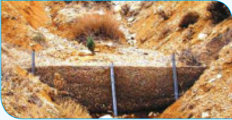
Resim 2.47: Kafes Tel Eşik Tesisi, Ahırdağı - Kahramanmaraş
