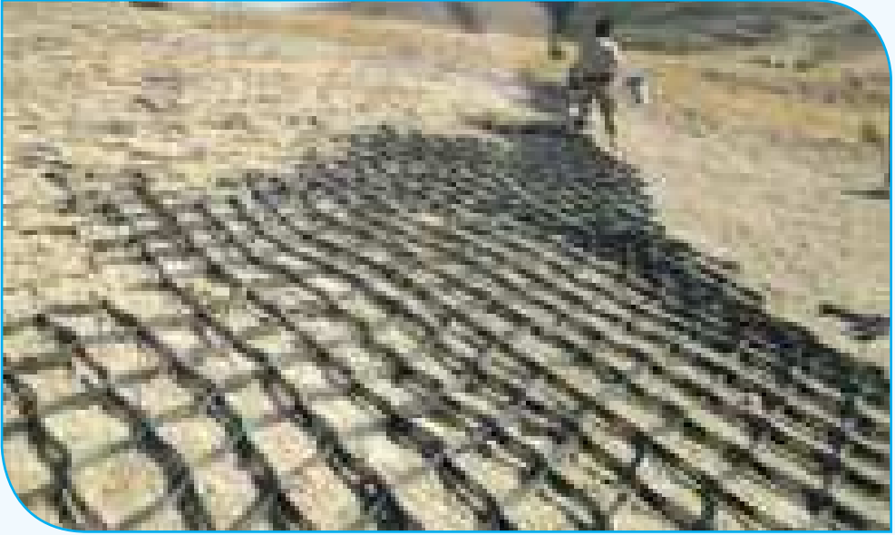
Resim 2.19: Geosentetik Hücre İle Yüzey Kaplama
