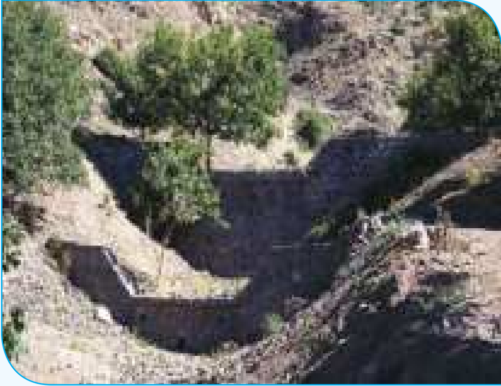
Resim 2.71: Eşik Yapımında Savak Boyutu İyi Hesap Edilmelidir.
