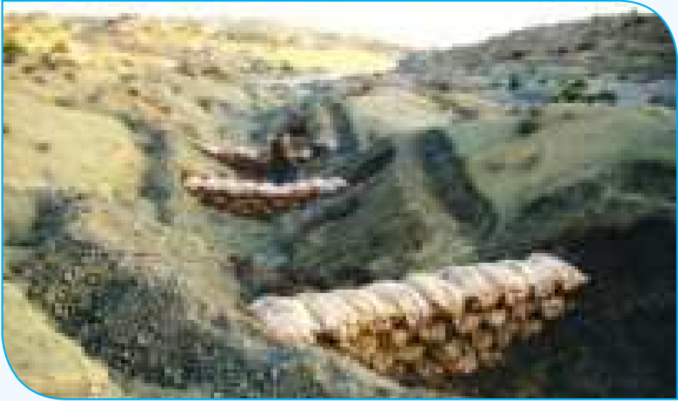
Resim 2.49: Çuvallı Sedde Tesis, Menzelet Baraj Havzası - Kahramanmaraş
