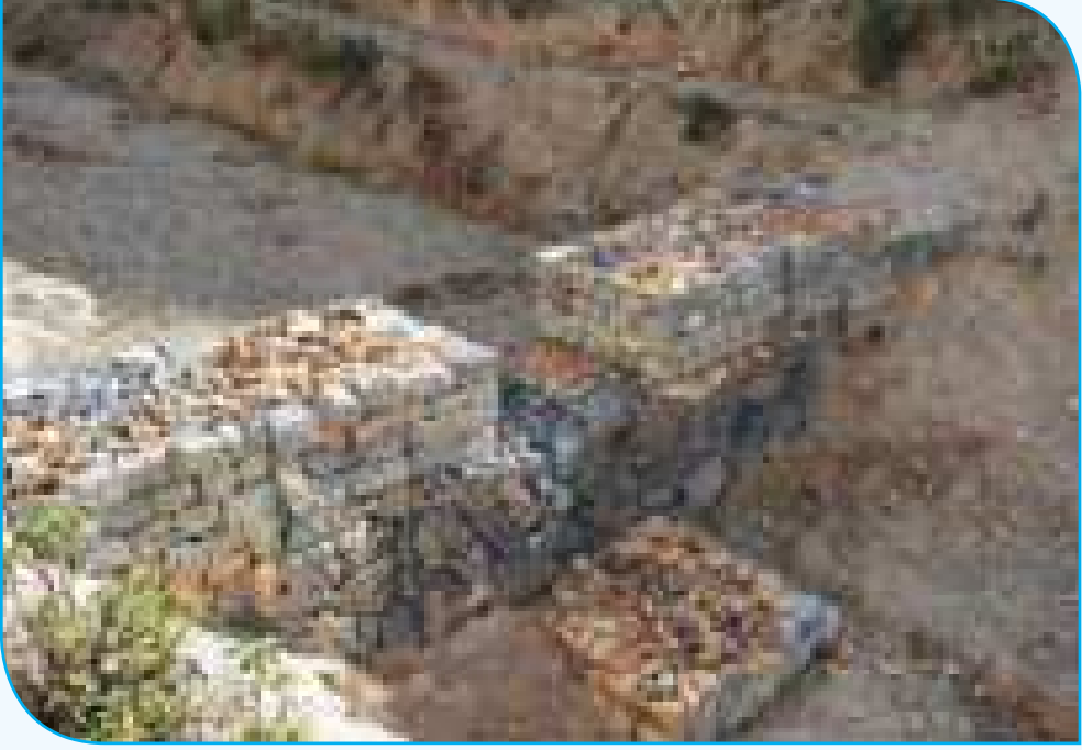
Resim 2.44: Kutu Gabion, Taşoluk - Afyon - 2015
