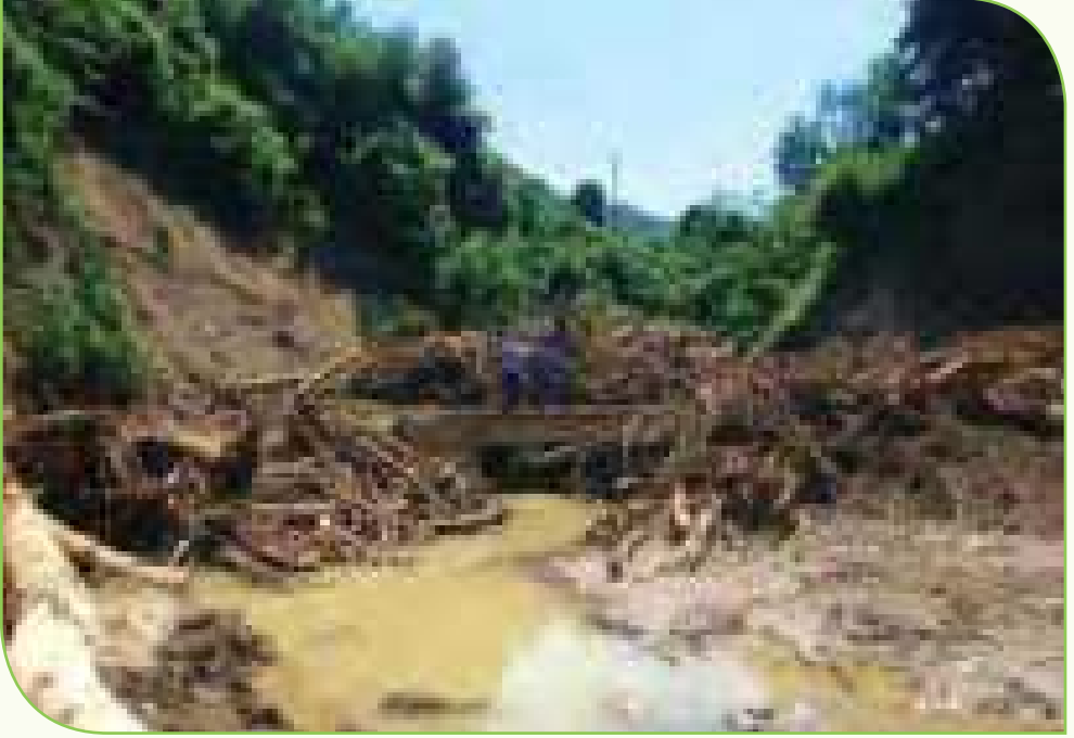
Resim 1.15: Dere Yatağına Uygun Ölçüde Yapılmayan Köprü ve Menfezlerin Neden Olduğu Sel ve Taşkın
