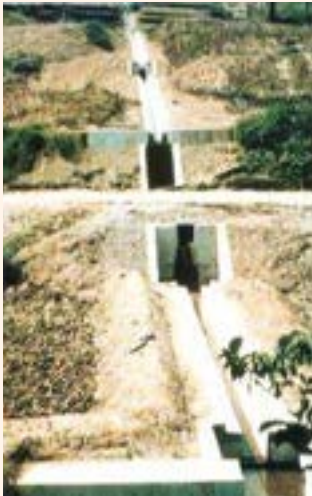
Beton drenaj kanalı
