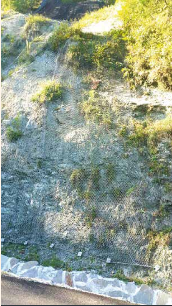
Çelik kafes tel ile yüzey kaplaması
