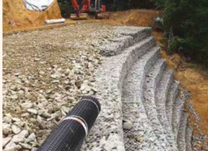
Geotekstil takviyeli Gabion teras duvar
