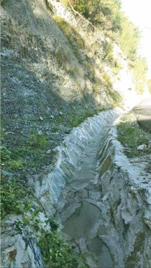
Taş pere kaplamalı açık drenaj kanalı
