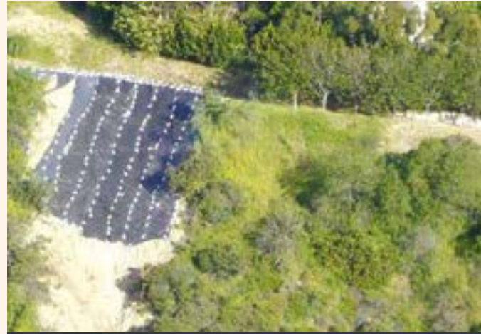
Geotekstil yüzey kaplaması
